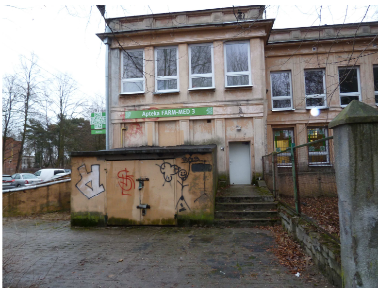
Widok od północnego - zachodu
